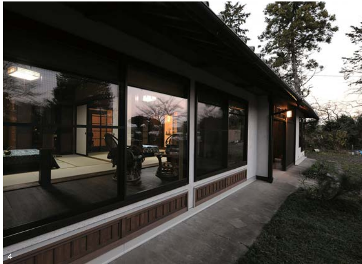
1.耐震補強の壁が開放感のある広縁をつくった。2.大きなソメイヨシノはご近所の花見場所にもなっている。3.楽しくリフォームを振り返るご夫婦。4.断熱サッシ、床板の隙間のふさぎ、広縁は生活空間温熱パuffersの役割とした。
