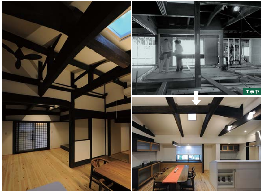
北側で寒く暗かったコタツリビングとダイニング。従前のリフォームで付けた天井を外し、光を反射する白色の断熱強化した勾配天井に。
